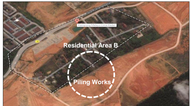
c) Kampung Melayu Lima Kedai (piling works)
