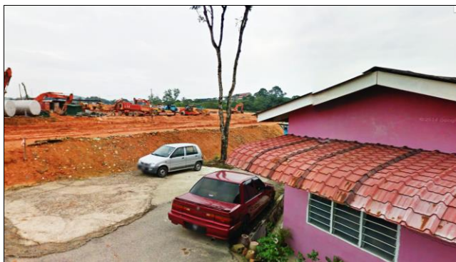
b) Kampung Melayu Lima Kedai (earthworks)
